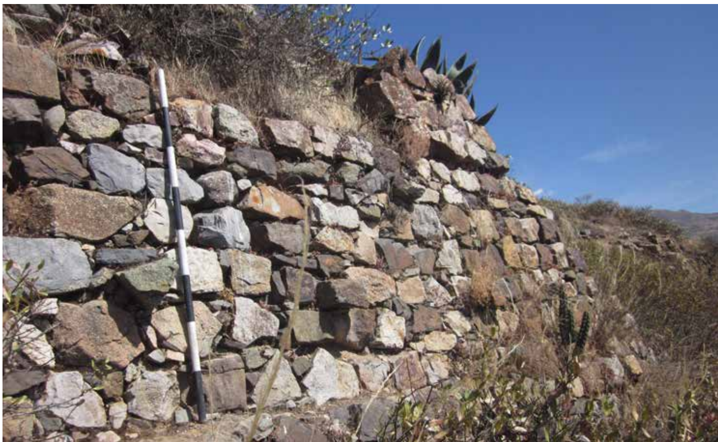
Muros de Chupacoto
